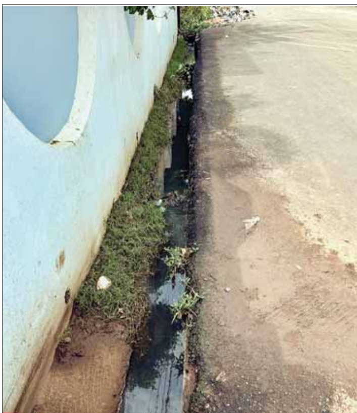
पानी को निकासी के लिए बनाई गई नालियों का व्यवस्थित निर्माण नहीं किया गया है। नालियों उतार चढ़ाव में तो कई जगह आवश्यकता के अनुसार मोड़ कर बनाई गई है। ऐसे में नालियों में जाने वाला पानी का बहाव सही नहीं होने के कारण पानी नालियों
